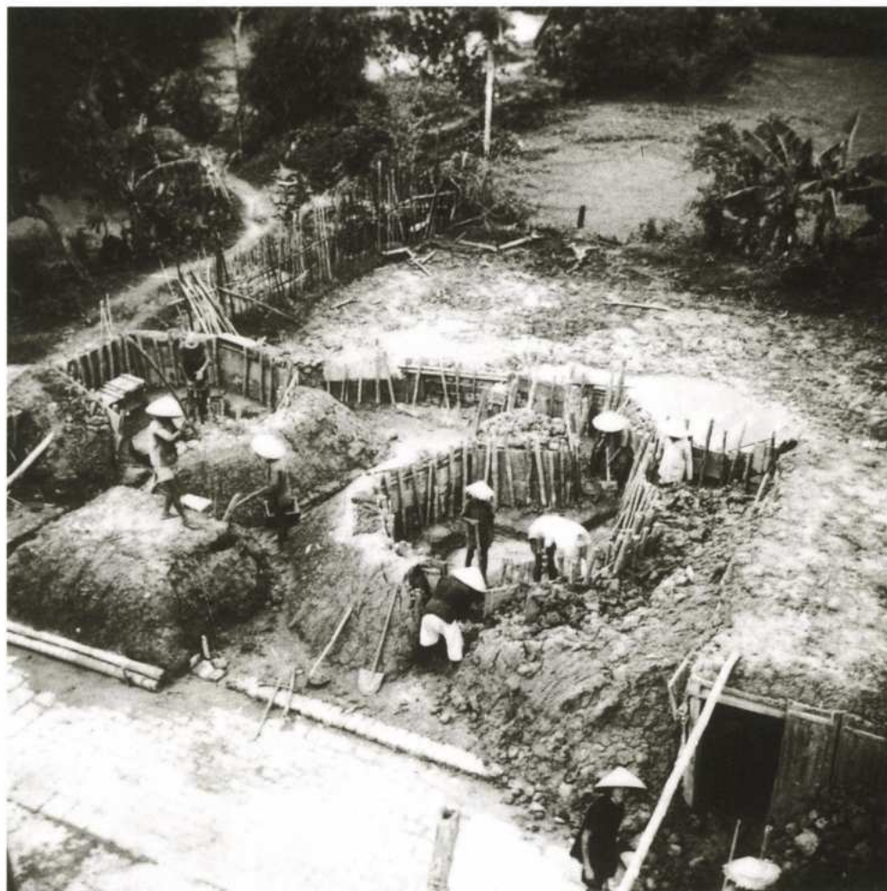
Point d'appui de Doan Xa en cours de construction.
