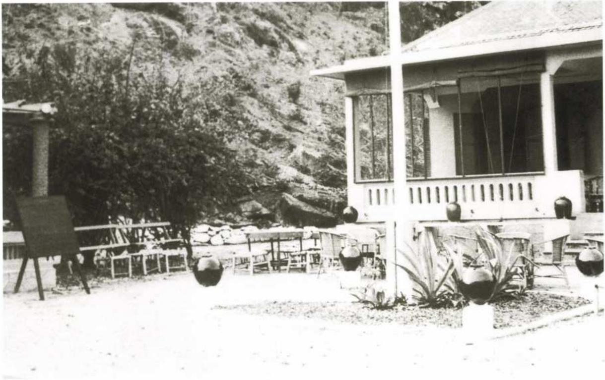
Le centre de repos du Cap Saint-Jacques où le 8 e GCP s'installe pendant sa formation commando. Ce bâtiment sera transformé en mess.
